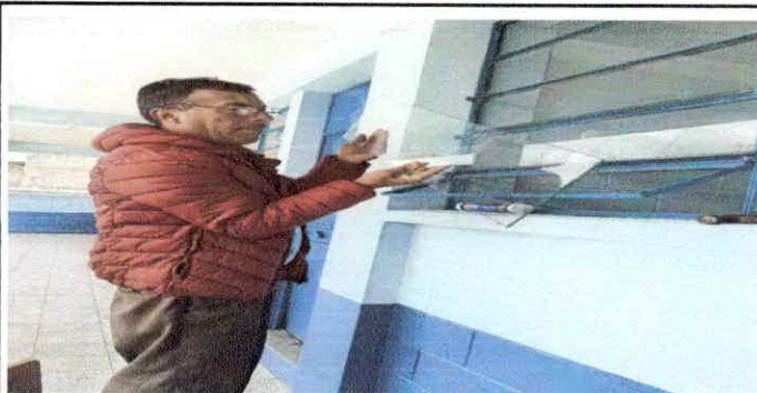
Foto 5: Sustitución de vidrios
