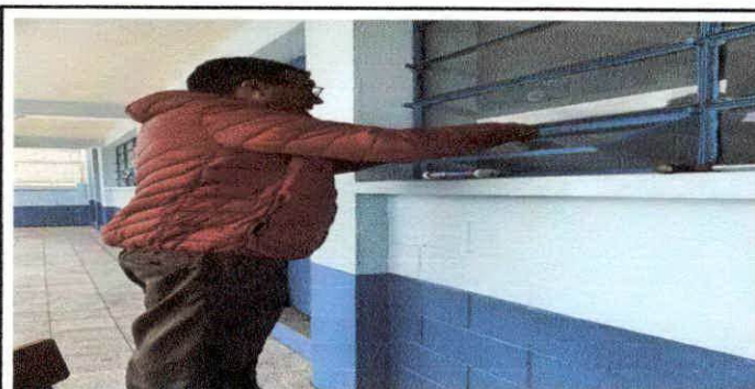
Foto 6: Sustitución de vidrios
