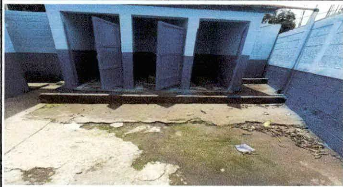
Foto 1: Pintura en muros exteriores e interiores
