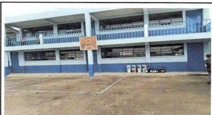
Foto 4: Pintura en muros exteriores e interiores
