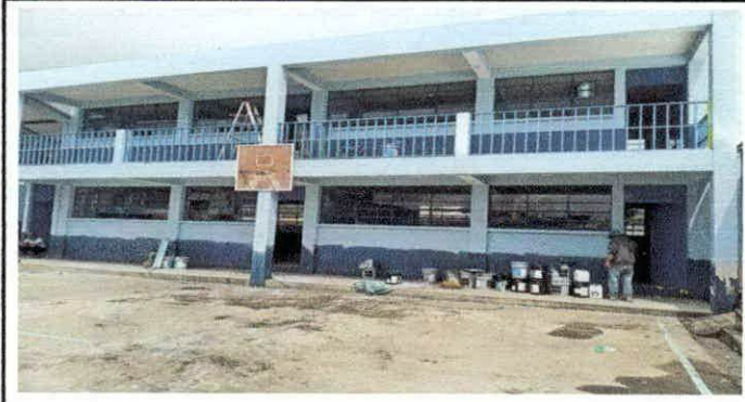
Foto 2: Pintura en muros exteriores e interiores
