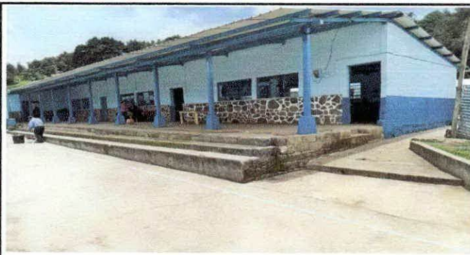
Foto 3: Pintura en muros exteriores e interiores
